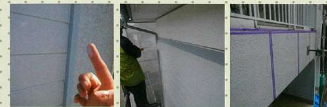
このように白い粉がつくようになると塗替えが必要です。 高圧洗浄中。 コーキングの打ち替え作業中です。
