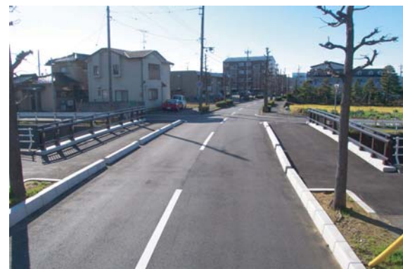
ジョイントレス構造施工例
