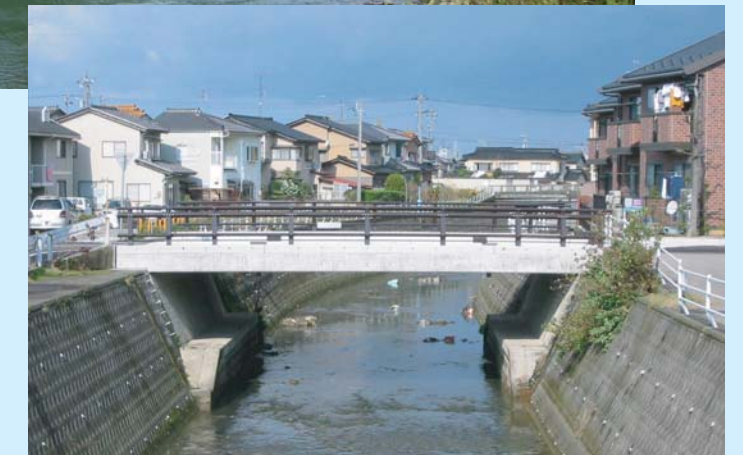
太郎田橋上部工架替工事 橋長13.10m 石川県金沢市(平成16年9月架橋)
